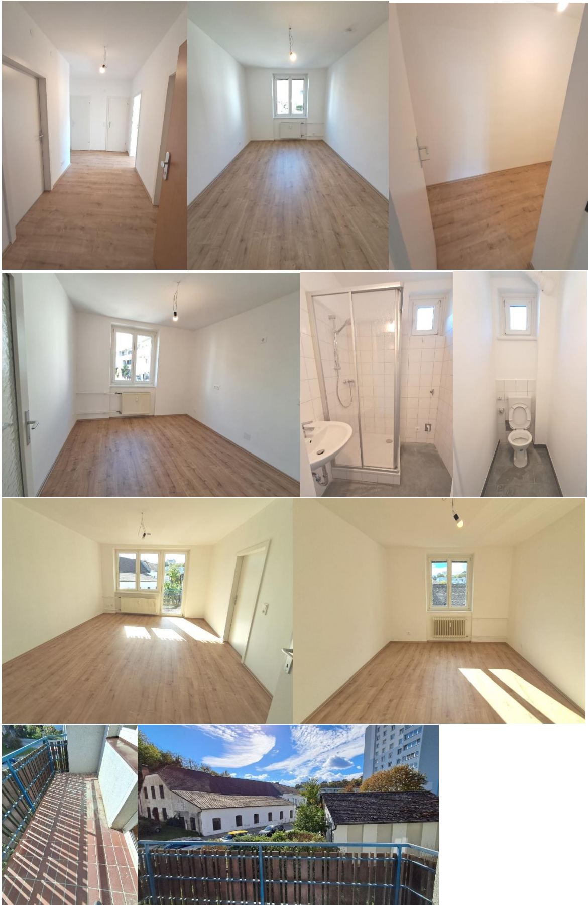
WHG. UFERGASSE 11/4, 3500 KREMS – Fertigstellung der Sanierung, Mitte Okt. 2026
