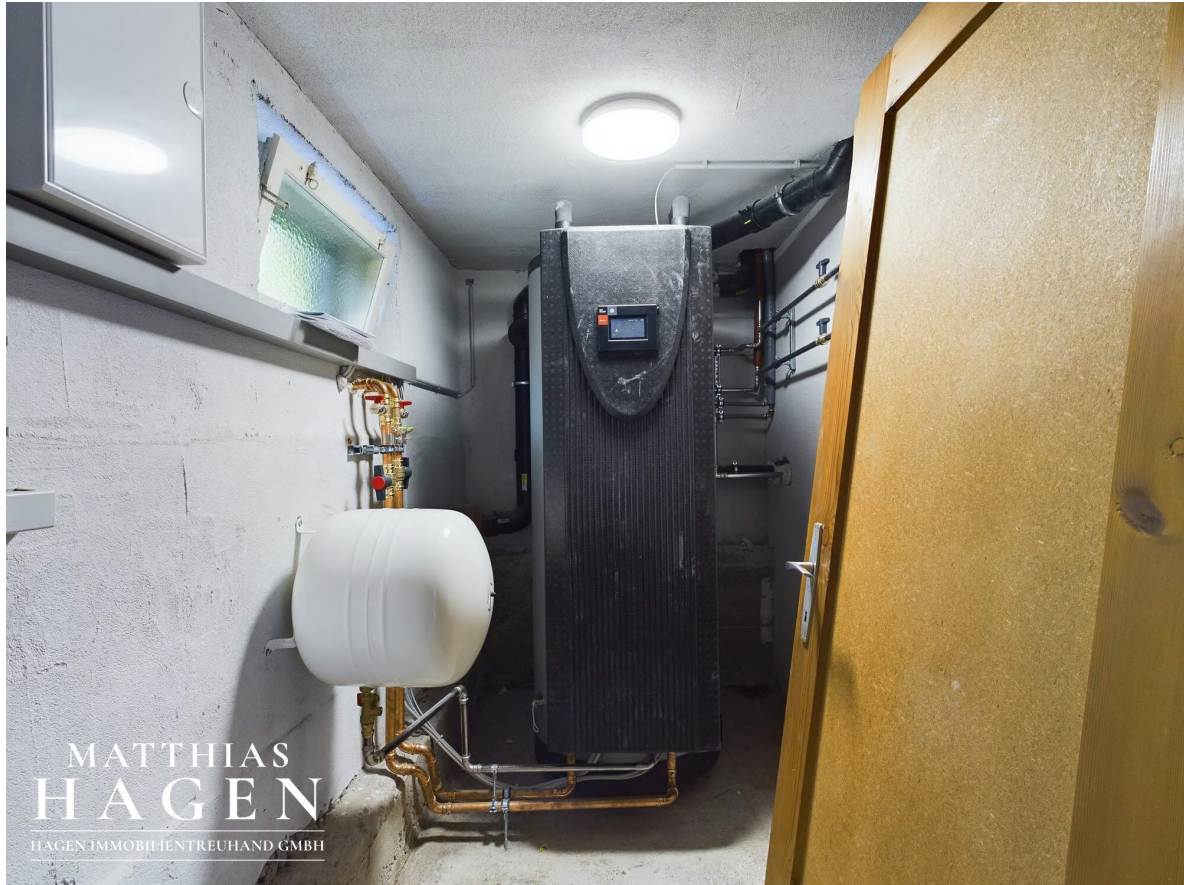
Heizraum - Luftwärmepumpe
