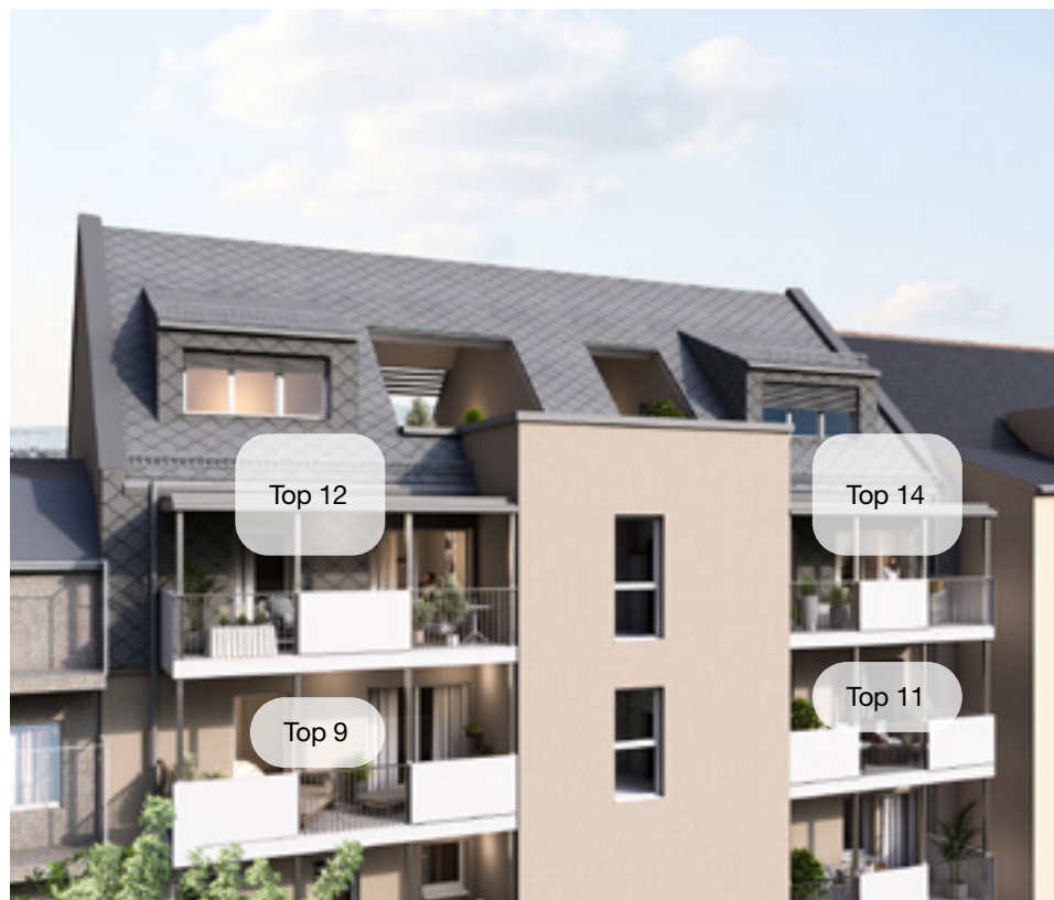
Ansicht Nord, Innenhof
